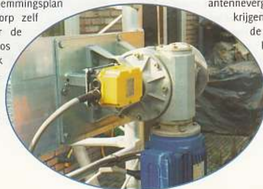
Detail van het aandrijfmechanisme
